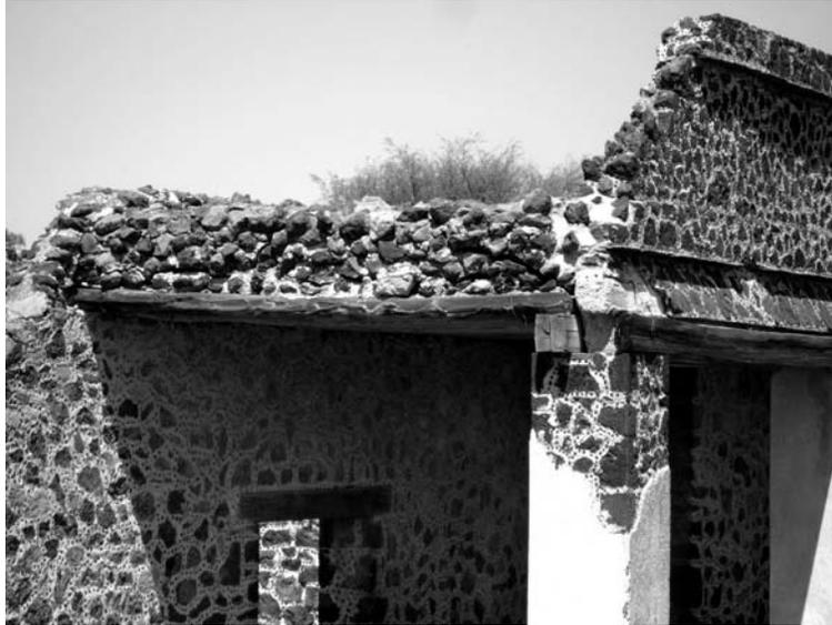
*Figura 4.1.* Fotografía del techo reconstruido en el Palacio de Quetzalpapálotl.
