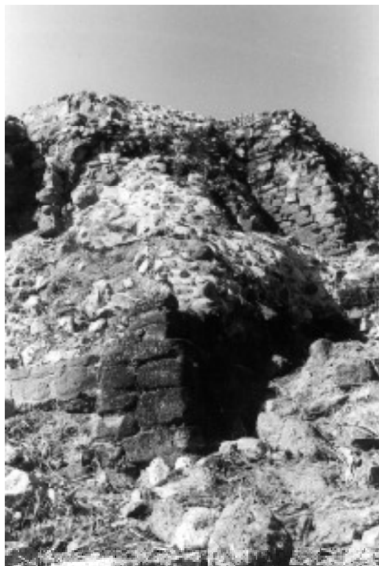
Fotografía 9. El Tigre, subestructura de la Estructura 2.
