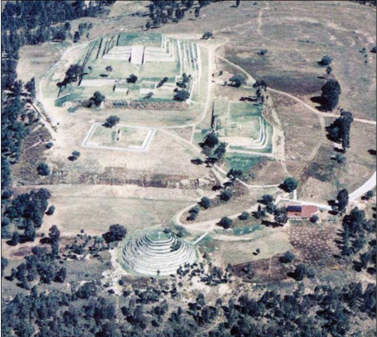
Figura 43. Durante la primera ocupación del sitio Xochitecatl-Cacaxtla, los pobladores del valle edifican en la cima del cerro Xochitecatl la Pirámide de Las Flores, El Basamento de Los Volcanes, el Edificio de La Espiral y el Edificio de La Serpiente, los cuales, en su conjunto, corresponden a la fase Zahuapan. Por otro lado, en la segunda etapa ocupacional denominada Atoyac, la Pirámide de Las Flores y el Basamento de Los Volcanes son ampliados con construcciones adicionales y siguen siendo utilizados, el Edificio de la Espiral y el Edificio de la Serpiente son abandonados.
