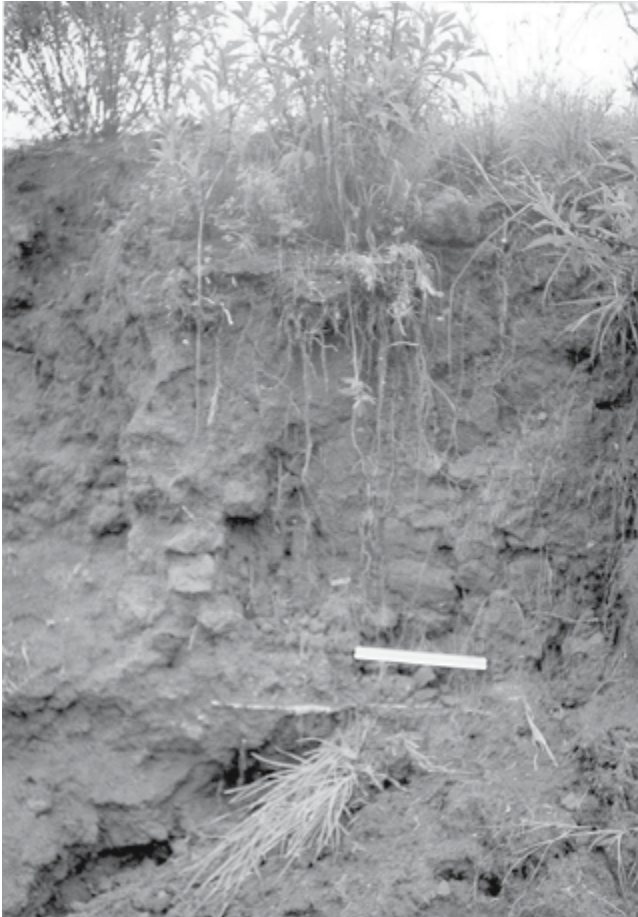
Figura 28. Los nuevos caminos de terracería y el uso de piedra careada destruyen los muros y pisos de estuco del sitio de Tetlatlahuaca.
