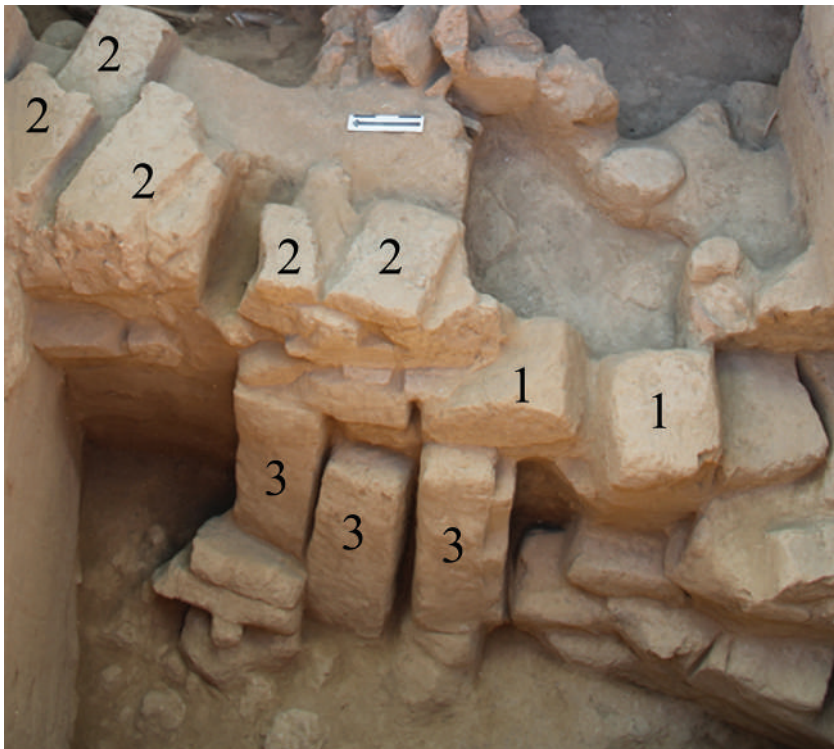
Figura 17. Muro de adobe en el lado oeste de la acrópolis que contiene los tres tipos de bloques (tomado de Joyce et al. 2016: figura 3.4).
