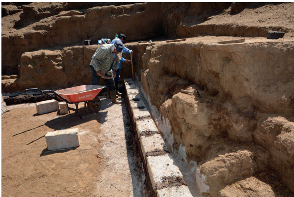
Figura 6. Rellenar con tierra blanca el espacio entre la parte original y los adobes colocados (A. Ichikawa).
