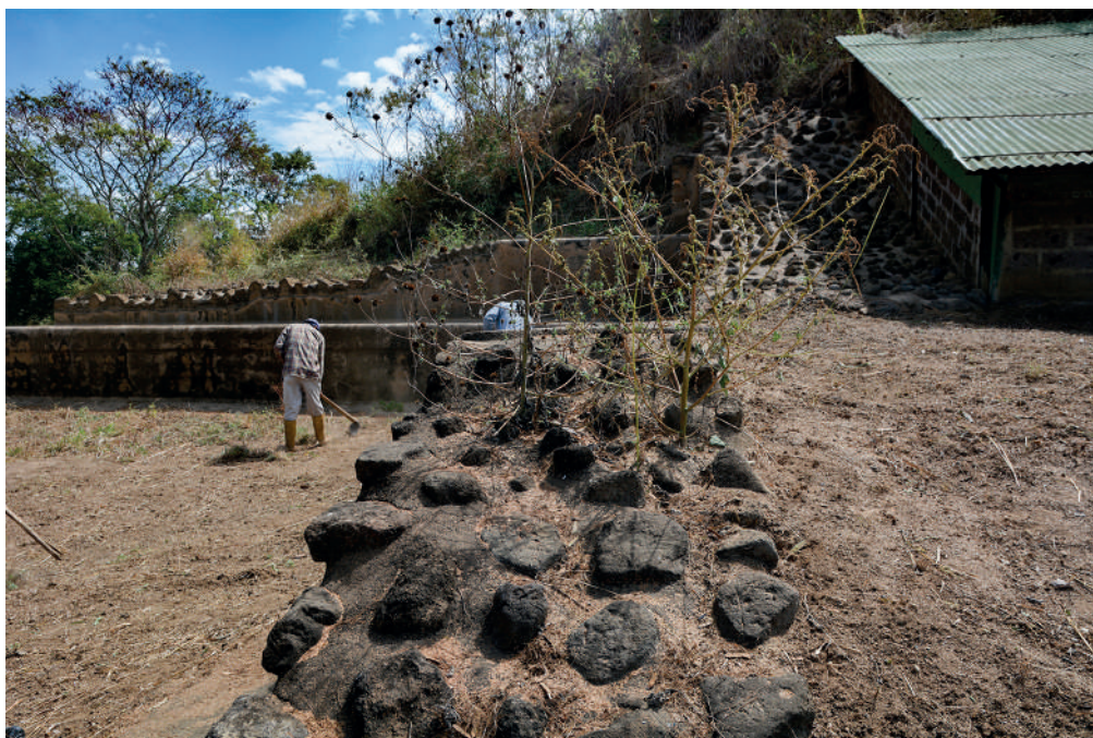
Figura 20. Maleza creciendo en las juntas del recubrimiento de piedras (A. Ichikawa).
