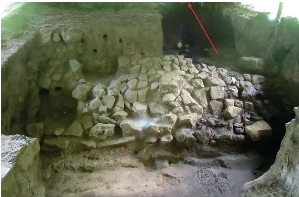
Figura 33. Ventana arqueológica ubicada al este de la Estructura 5, donde se observa la filtración de agua de lluvia entre el techo de lámina y la tierra del núcleo del montículo (S. Shibata).
