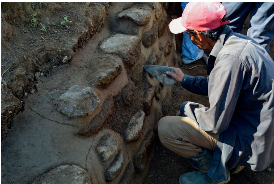
Figura 15. Dejar rayas marcadas en el mortero para distinguir entre piedras originales y piedras colocadas para el proceso de intervención (A. Ichikawa).
