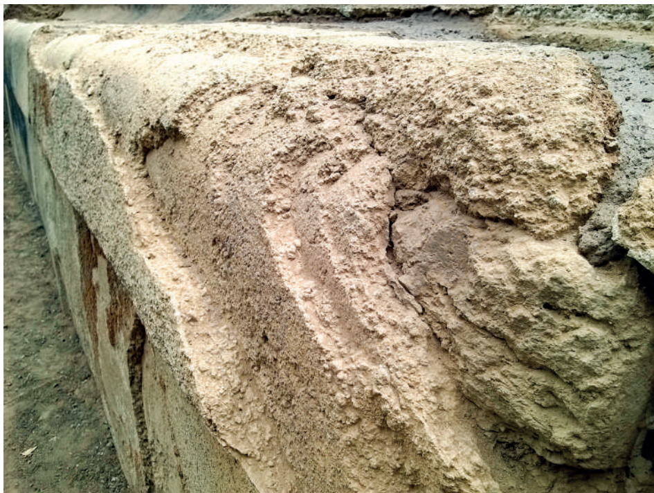
Figura 11. Repello aplicado en la Estructura 17 (O. Camacho).
