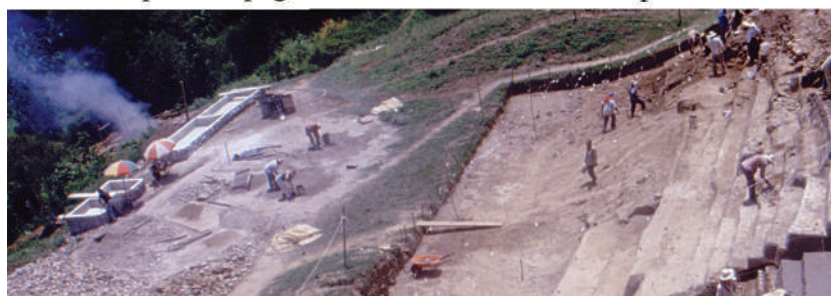
Figura 23. Amontonamiento de conchas de ostión; elaboración de tapesco con cáscaras de coco y hojas de palma secas; quema de tapesco para hacer cal viva; empacado de cal en costales de papel y en yahua (espata fibrosa de la palma real o Roystonea regia ) y artesas para apagar la cal durante los trabajos de campo en 1994 en el lado sur de la Gran Acrópolis (M. J. Gallegos y R. Armijo).
