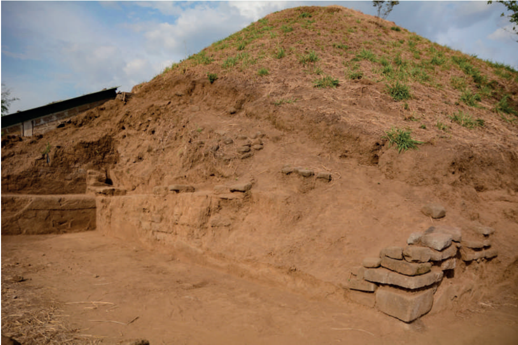
Figura 2. Restauración prehispánica en la esquina suroeste de la Estructura 5 (A. Ichikawa).
