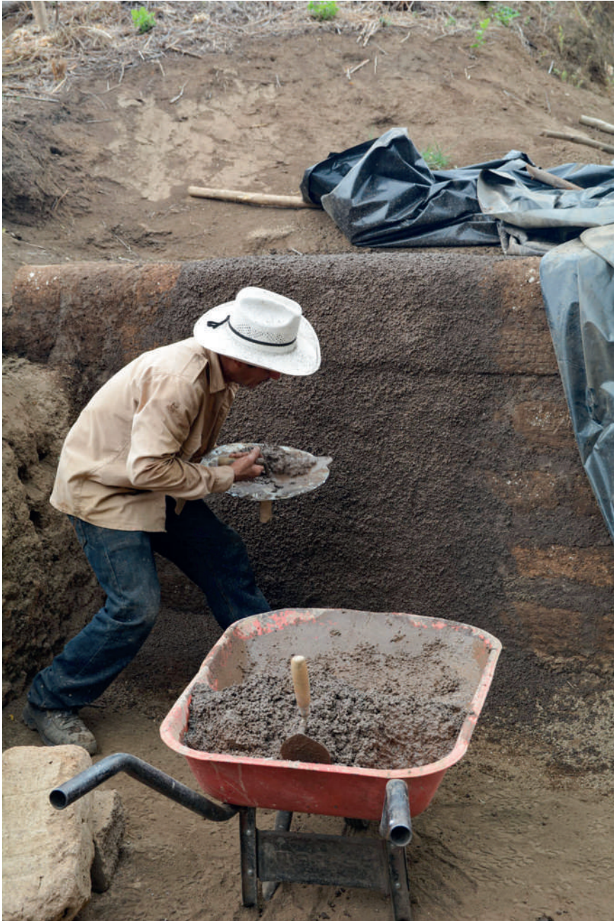
Figura 8. Repellado de la pared de adobes (A. Ichikawa).
