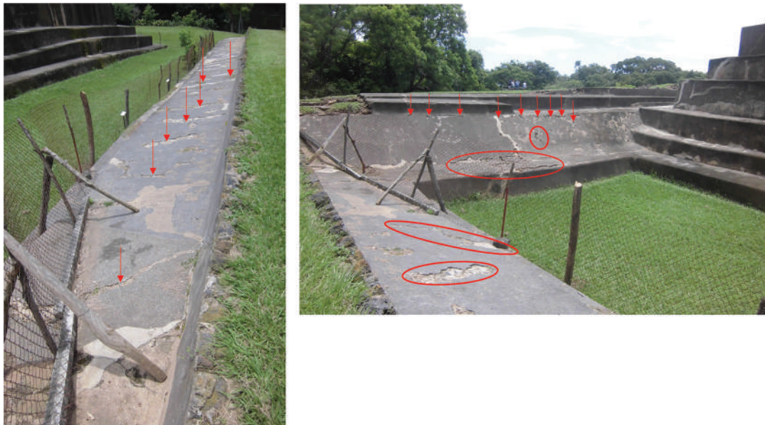
Figura 20. En el área de la supuesta cancha de juego de pelota ubicada al sur de la Gran Pirámide B1-1 se observa el desprendimiento de repello de cemento y fisuras (S. Shibata).
