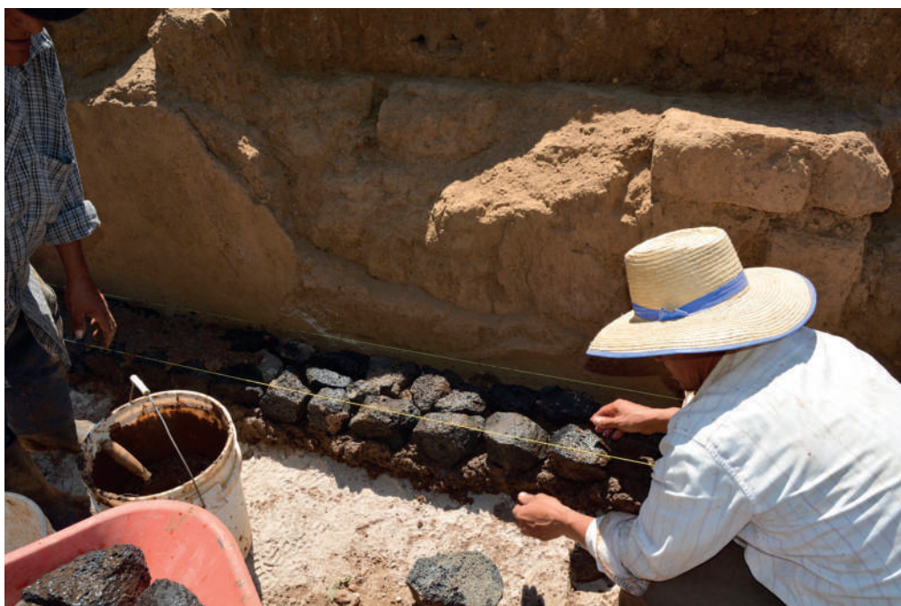
Figura 4. Fundación de piedra para colocar bloques de adobes (A. Ichikawa).
