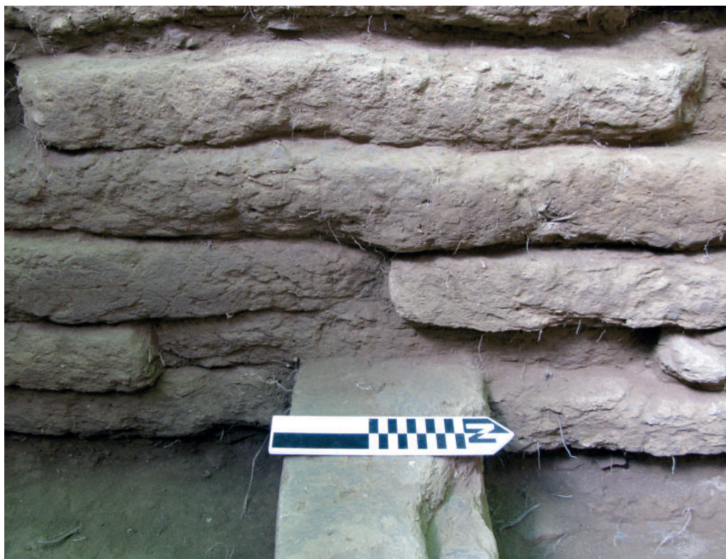
Figura 13. Detalle del muro de cajón de la plaza del complejo Cerro Grande. Los adobes fueron colocados en hiladas sencillas o a “soga”, y casi contrapeados (imagen del PATP ©), (Kabata y Murakami 2014: 42).
