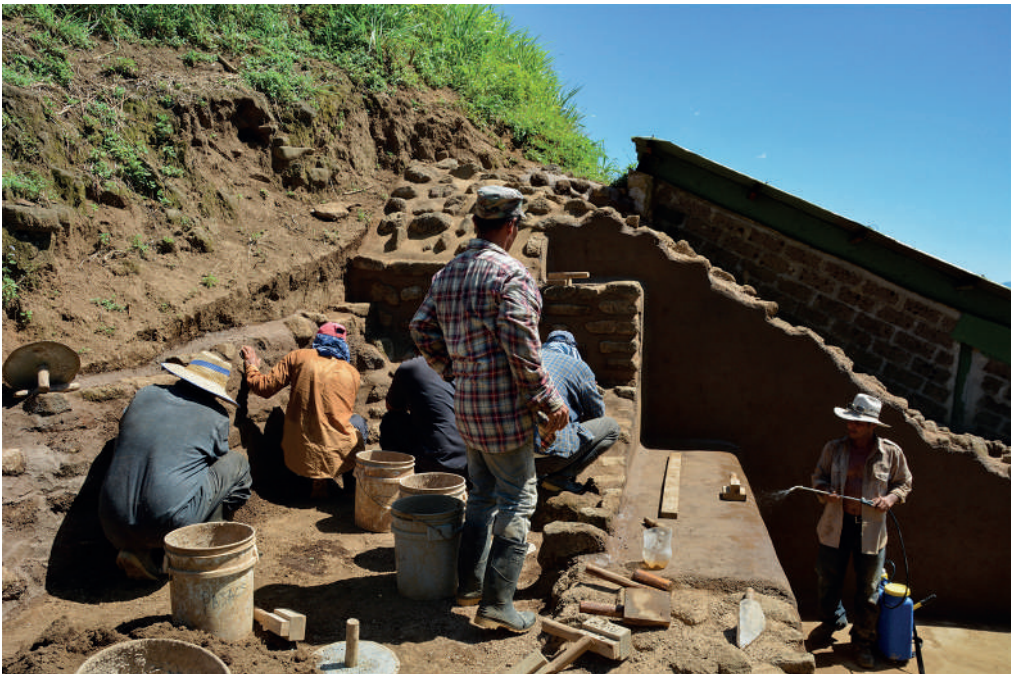
Figura 14. Compactar las juntas de tierra entre piedras con mazos de madera (A. Ichikawa).
