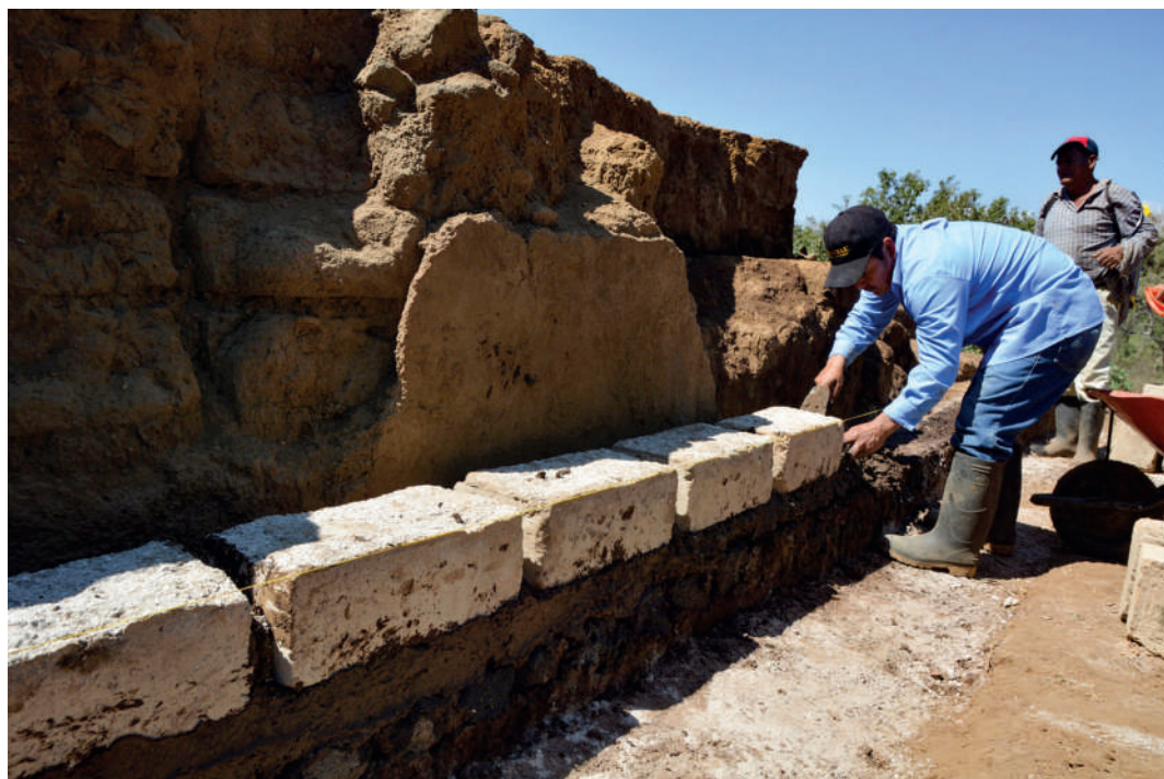
Figura 5. Levantamiento la pared de adobes (A. Ichikawa).
