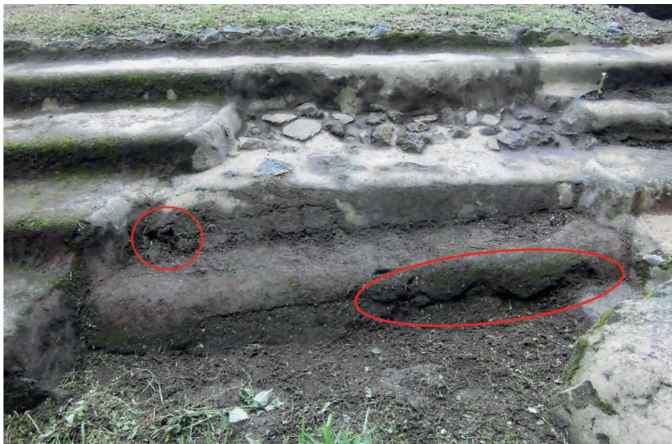
Figura 31. En la primera y segunda gradas del primer cuerpo de la Estructura 5c se registran fisuras (S. Shibata).
