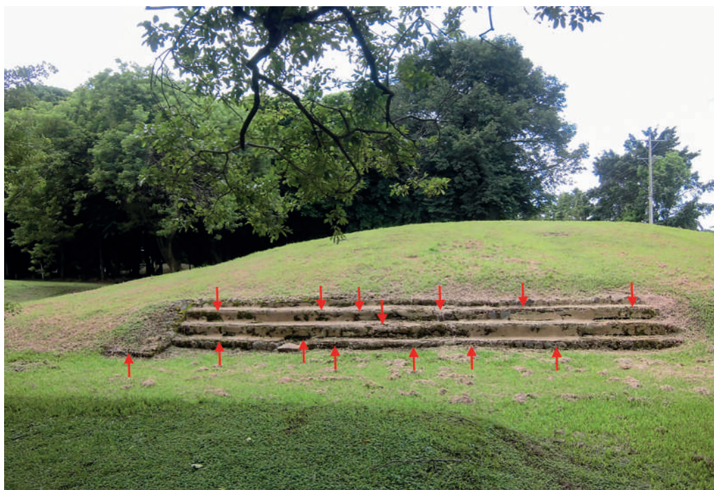
Figura 27. Lateral norte de la escalinata de la Estructura 2 (S. Shibata).
