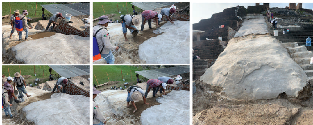
Figura 24. Proceso de restauración arquitectónica de la alfarda sureste del Templo I de Comalcalco en 2020 (R. Armijo).
