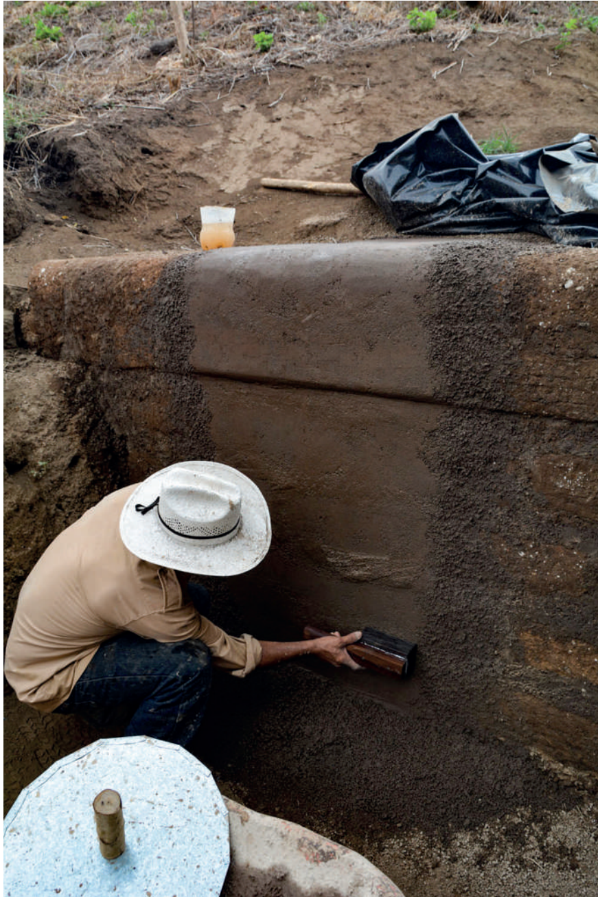
Figura 9. Compactación de la pared con mazo de madera (A. Ichikawa).
