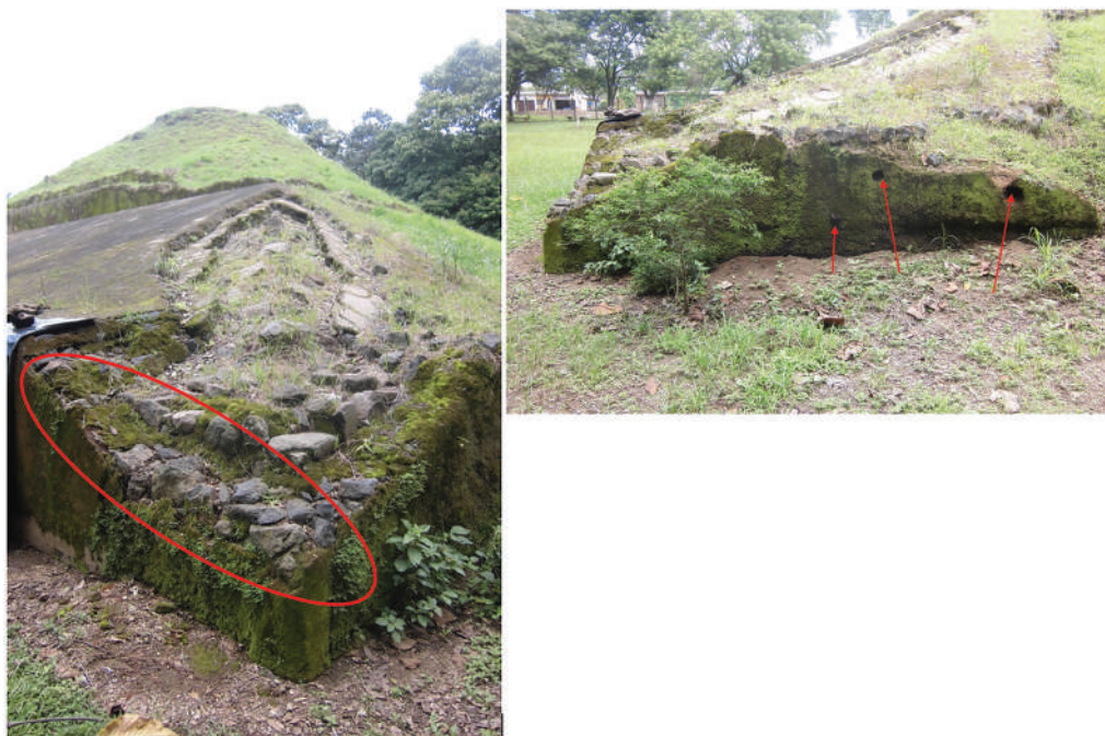
Figura 26. En la esquina noreste de la Estructura 1, el repello de reconstrucción que cubría piedra desapareció (S. Shibata).
