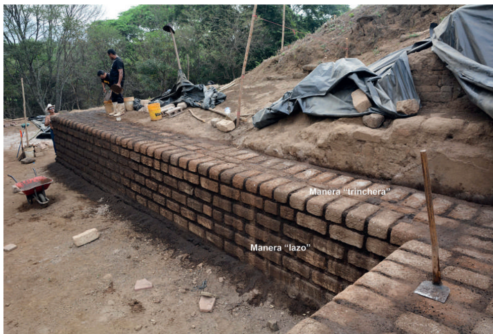
Figura 7. Proceso de formar el andador y el muro (A. Ichikawa). Se pueden ver partes rayadas para que se adhiera bien el repello.
