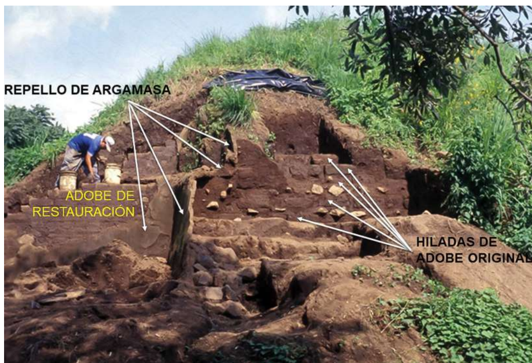
Figura 11. Sistema constructivo de las estructuras 5 a y 5b, Casa Blanca (S. Shibata).
