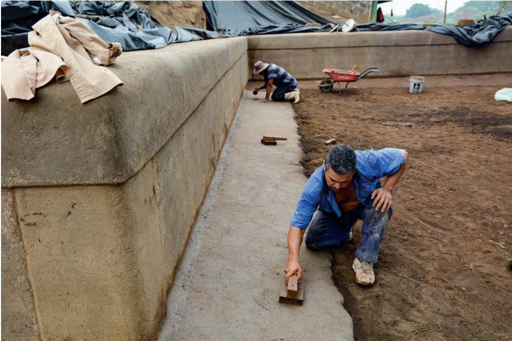
Figura 10. Rampa para garantizar un correcto desalajo de las aguas lluvias (A. Ichikawa).
