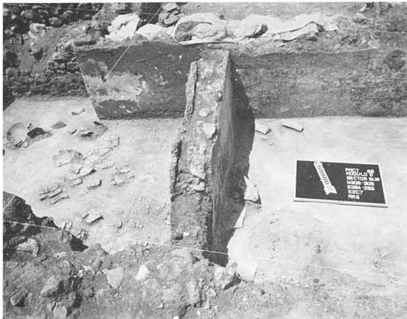
Figura 39. Murete divisorio entre C6 y C7, apoyado solamente sobre el muro norte. En el ángulo superior izquierdo se observa el tapiaje de C6.
