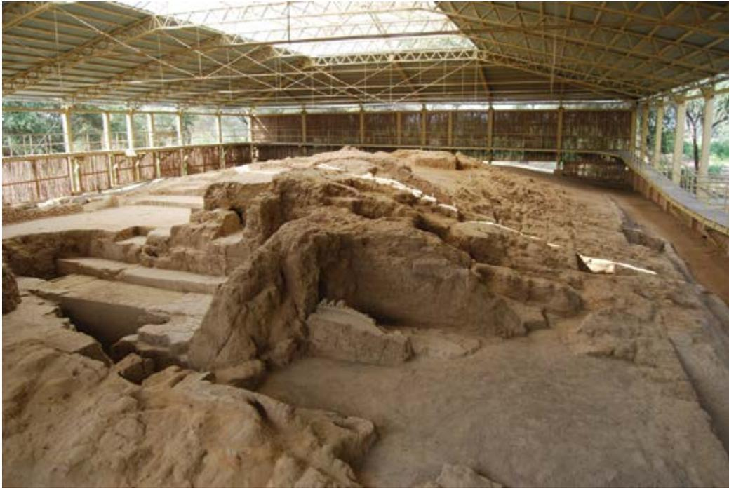
*Figura 9.* La combinación de estructuras de acero y elementos de bambú ha conseguido una adecuada conservación de la Huaca las Balsas en Túcume, Perú (fotografía Luis Guerrero Baca).
