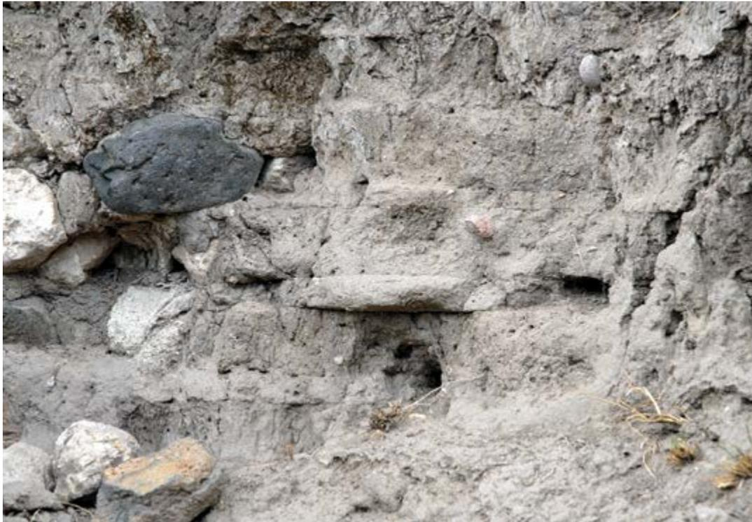
*Figura 21.* Muro sur del Edificio B; se aprecia la porosidad del adobe y la consistencia y dureza de las juntas de barro mejorado con arena. SECRETARÍA DE CULTURA.-INAH.-MEX. Reproducción autorizada por el Instituto Nacional de Antropología e Historia.
