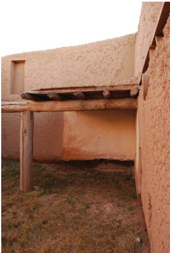
*Figura 3.* Los recubrimientos aplicados en una sección parcialmente cubierta de Paquimé, Chihuahua, presentan problemas en la base por absorción capilar y arrastre de sales (fotografía: Luis Guerrero Baca).
