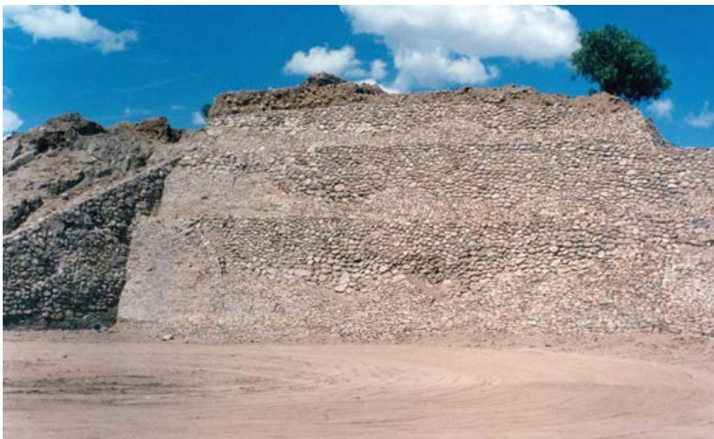
*Figura 7.* La fachada principal de la Pirámide de las Flores destaca por presentar un recubrimiento de lajas colocadas sin cementante.
