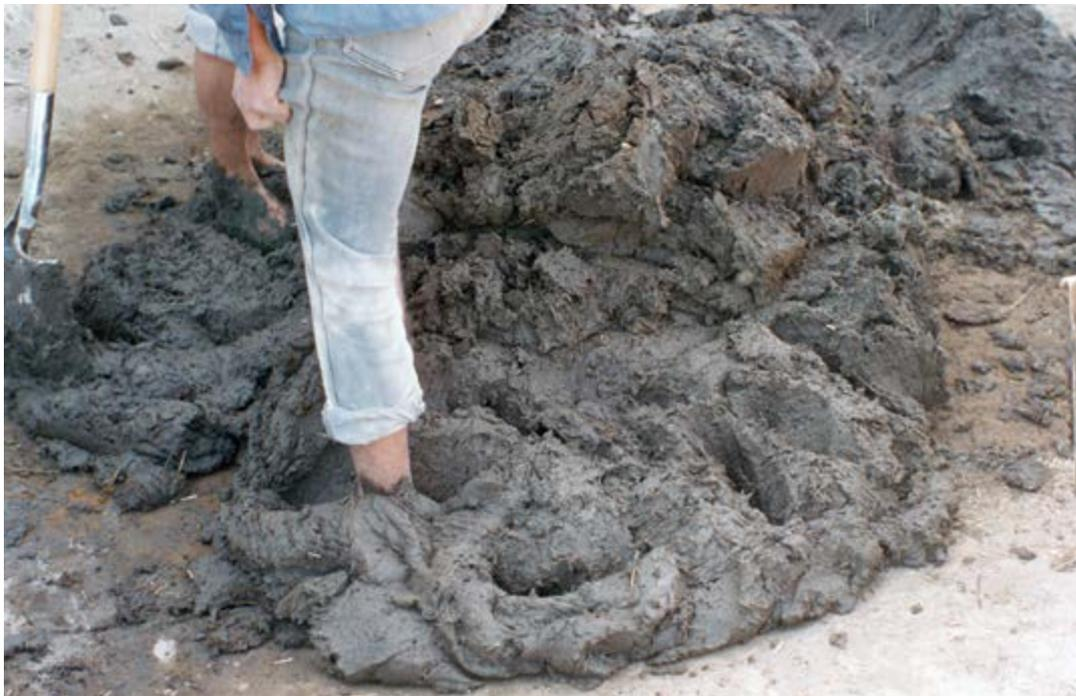
*Figura 14.* Detalle de la preparación de la argamasa.
