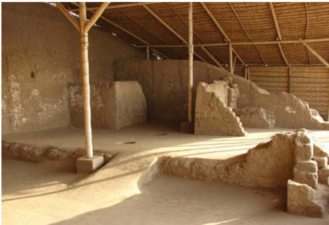
*Figura 4.* Cuidadoso diseño y colocación de las bases de los apoyos verticales en las techumbres de bambú en las Huacas de Moche, Trujillo, Perú (fotografía: Luis Guerrero Baca).
