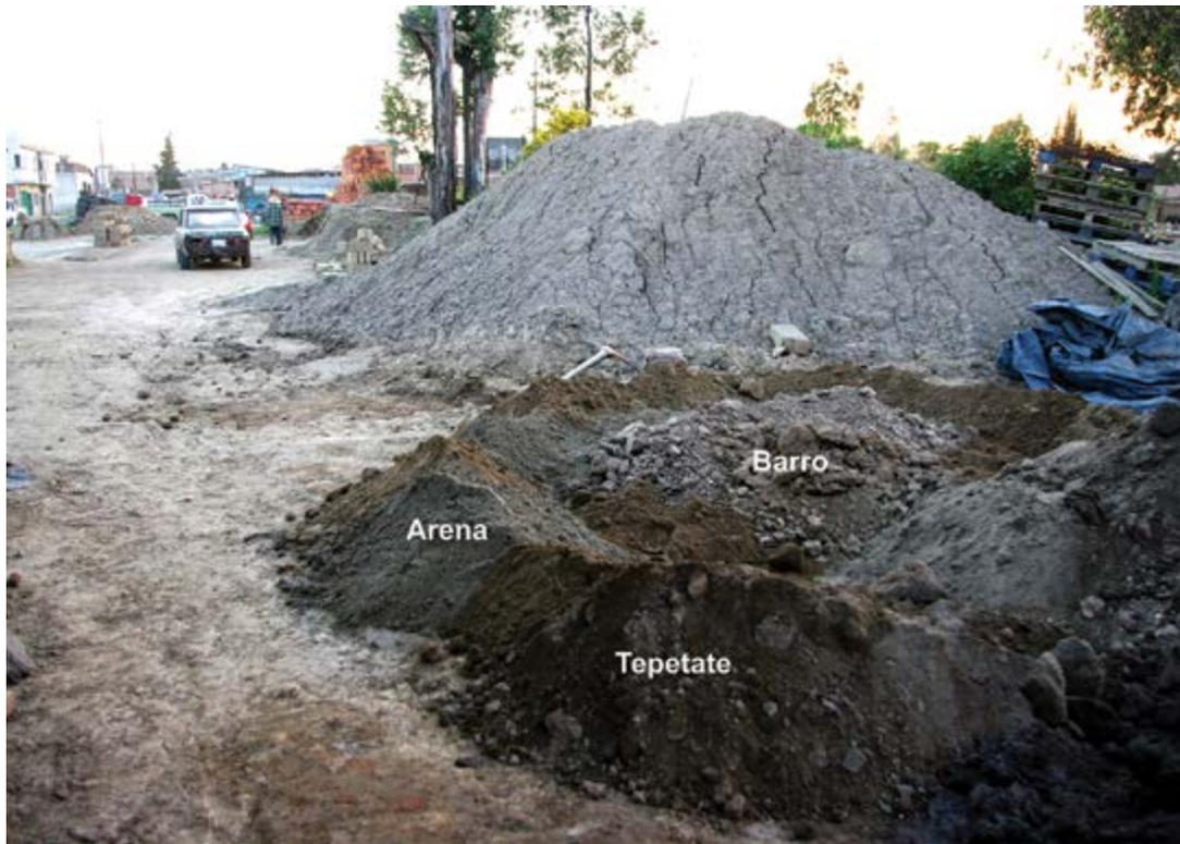
Figura 29. “Rampa” de preparación de la mezcla para producir adobes.
