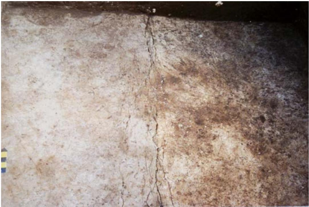
*Figura 31.* Estado de conservación del piso ubicado en el pozo realizado frente a la fachada de la plataforma II B, anexa al Edificio B. Se observa el agrietamiento del piso por los asentamientos de los depósitos de barro subyacentes; estas grietas coinciden con la arista de la plataforma de piedra que se localizó abajo. SECRETARÍA DE CULTURA.-INAH.-MEX. Reproducción autorizada por el Instituto Nacional de Antropología e Historia.
