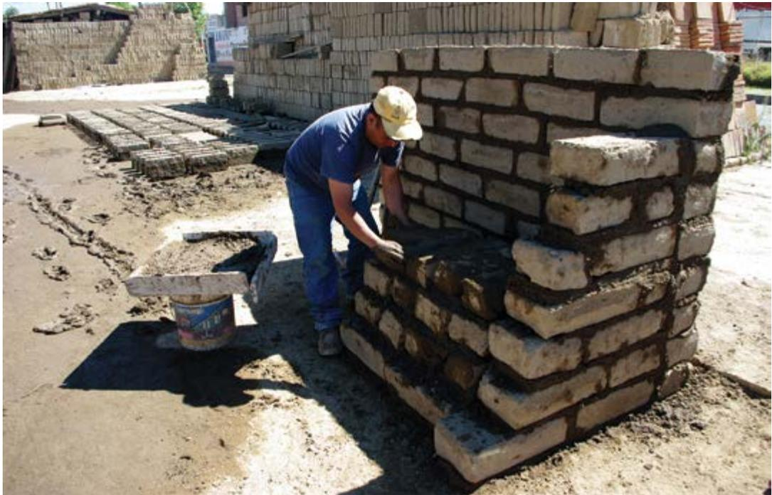
*Figura 33.* Construcción de muro sencillo de celda y muros bajos de talud.
