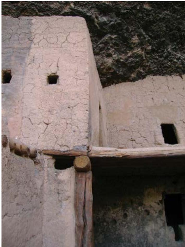
*Figura 2.* Las estructuras localizadas en Cuarenta Casas, Chihuahua, fueron recubiertas por sus constructores originales con revoques arcillosos, por lo que en la actualidad presentan notables fisuras (fotografía: Luis Guerrero Baca). SECRETARÍA DE CULTURA.-INAH.-MEX. Reproducción autorizada por el Instituto Nacional de Antropología e Historia.
