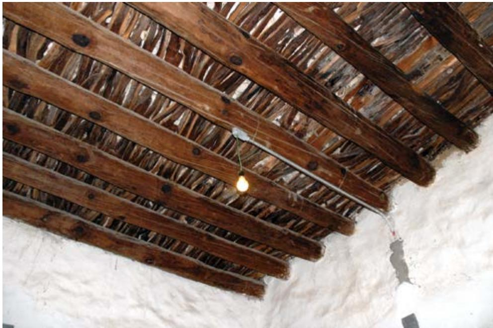
*Figura 29.* Cubierta de la sacristía de la capilla de Pino Suárez en donde se observa el sistema constructivo muy parecido a los elementos del registro arqueológico descubiertos por Acosta en Palacio Quemado o Edificio 3, ubicado en el sector central del recinto monumental de Tula.
