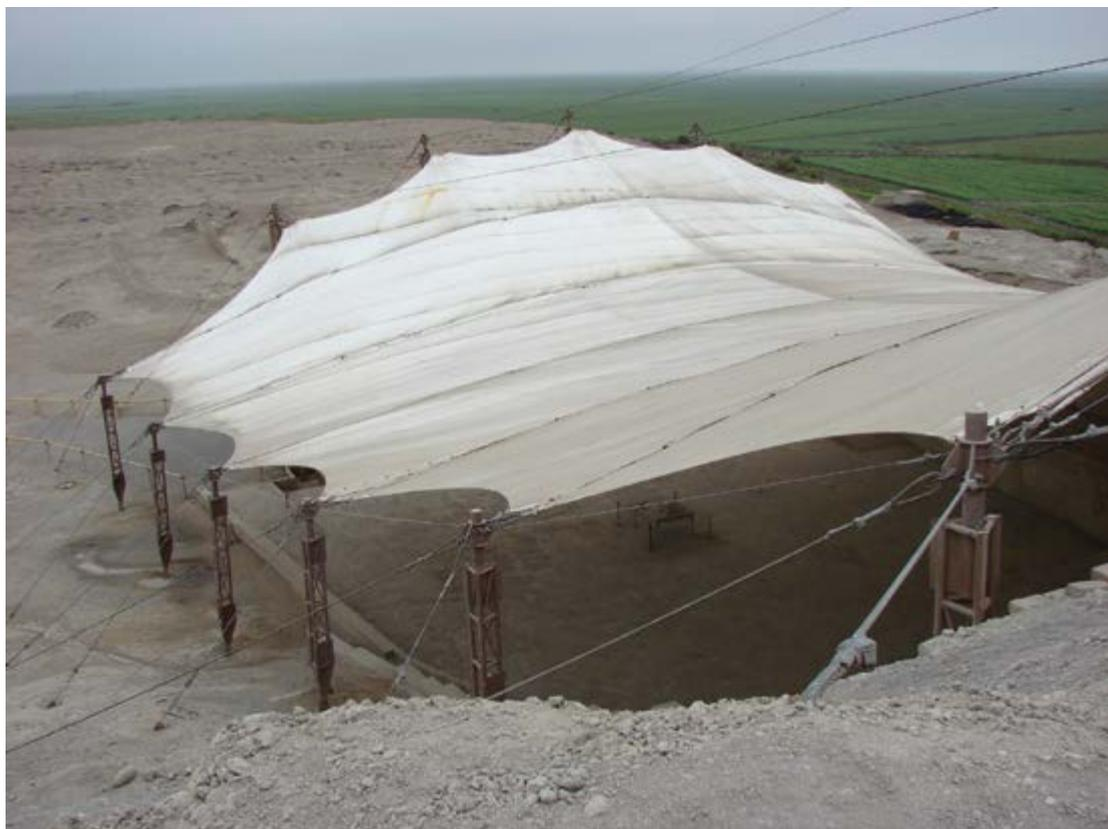
*Figura 7.* La cubierta de la estructura arqueológica de la Huaca Cao Viejo, Perú, ha generado problemas en el sitio asociados al flujo eólico y la generación de esfuerzos de tensión (fotografía: Luis Guerrero Baca).
