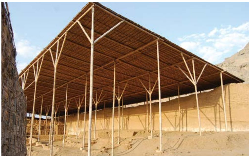
*Figura 10.* Sistema de cubiertas parciales diseñadas con materiales y sistemas tradicionales compatibles con las estructuras térreas. Huacas de Moche, Trujillo, Perú (fotografía: Luis Guerrero Baca).
