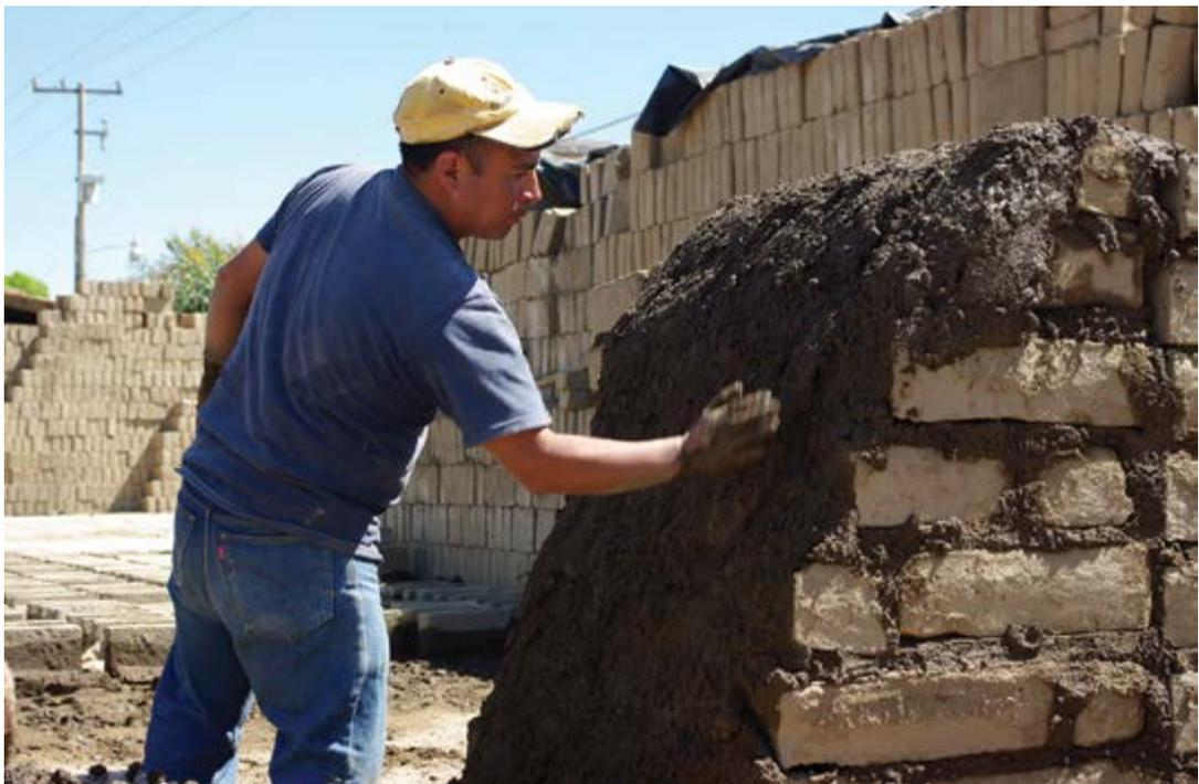
*Figura 34.* Colocación de recubrimiento de mortero.
