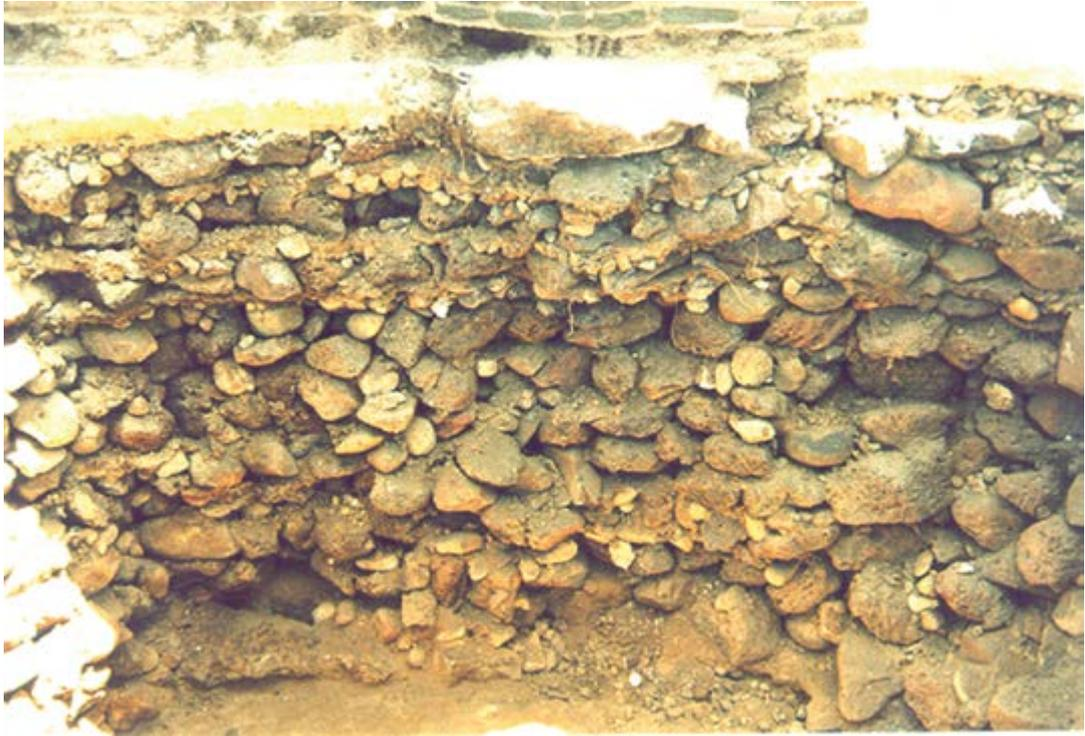
*Figura 11.* Cajas de piedra en donde se puede observar la composición de los rellenos realizados por una capa de piedra grande, después una de piedra chica y una de barro para sellar, este sistema se repite hasta alcanzar la altura deseada. SECRETARÍA DE CULTURA.-INAH.-MEX. Reproducción autorizada por el Instituto Nacional de Antropología e Historia.
